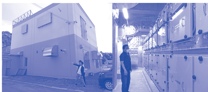
フィルター棟
